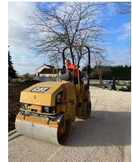
Pose de la bâche de protection, réception des 150 tonnes de grave calcaire et compactage au rouleau
