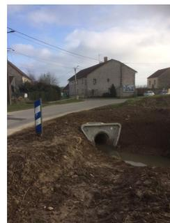
Travaux de la Jarrie, modification des busages pour un écoulement plus efficace sous la chaussée vers le bassin.
